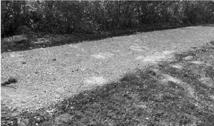
Die Boule-Bahn am See nimmt weiter Form an und rückt Stück für Stück dem Ziel näher. Vergangenes Wochenende wurde von mehreren engagierten Helfern Mineralbeton auf die Spielfläche eingebaut, nachdem die Grundfläche freigelegt und ausgegraben wurde. Als nächstes werden „Randsteine“ gesetzt, um den Bereich klar abzugrenzen. Schon bald wird ein Spielvergnügen von Groß und Klein wieder möglich sein – freuen Sie sich auf die ersten Partien!
